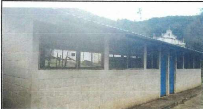
Foto 1: Sustitucion de ventanas de malla a metal con vidrios del Modulo 01.
