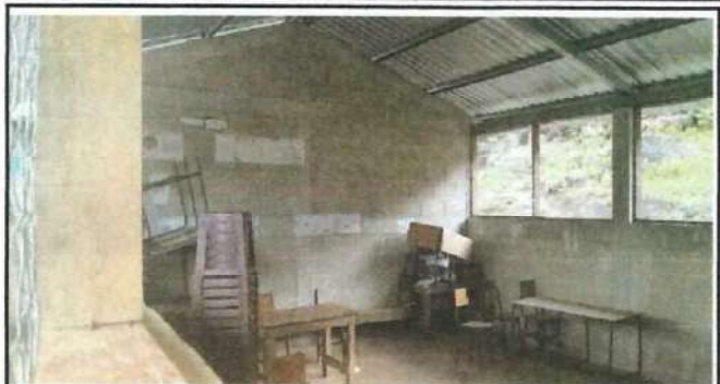
Foto 2: Sustitucion de ventanas de malla a metal con vidrios del Modulo 02
