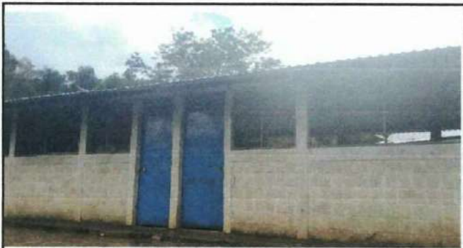
Foto 3: Colocacion de pintura del interior del modulo 01.
