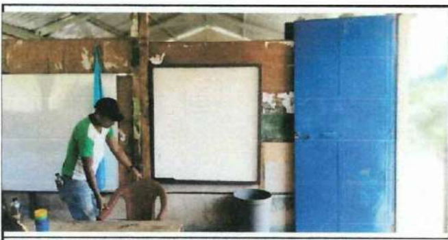
Foto 5: Colocacion de pintura en su interior del modulo 02.
